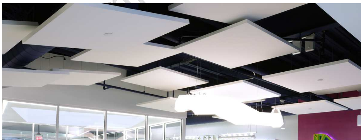
Obr. 10: Ukázka volně závěsných stropních akustických prvků
