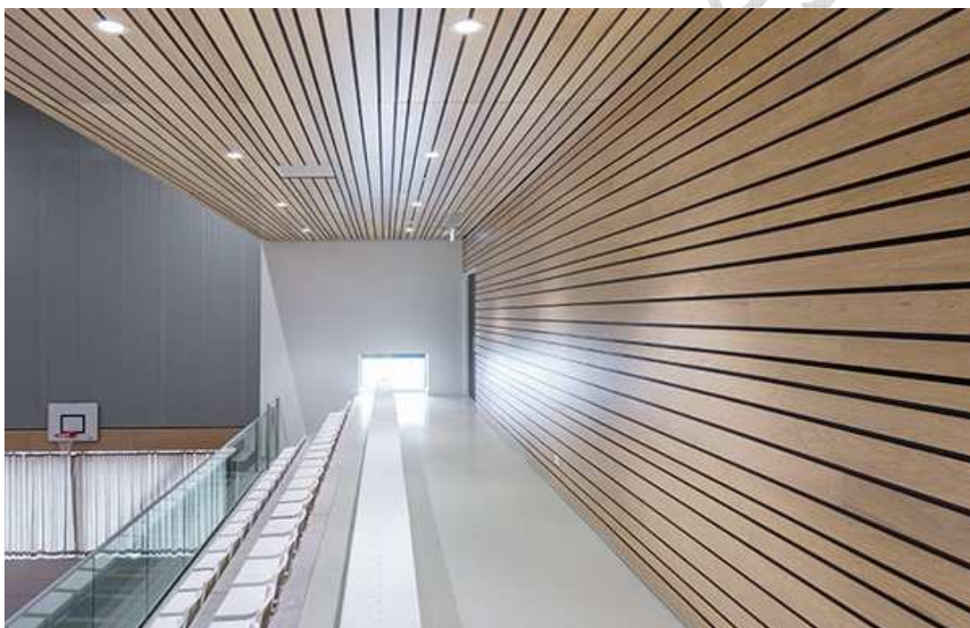
Obr. 5: Ukázka provedení štěrbinových nízkofrekvenčních rezonátorů
