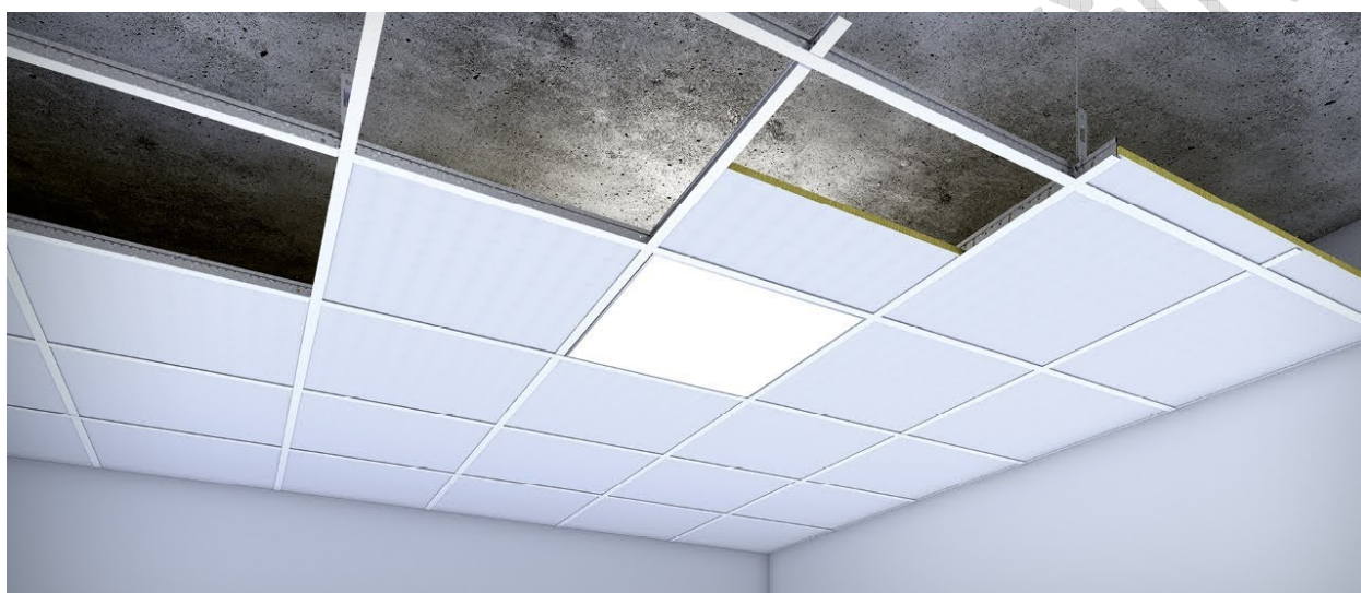
Obr. 9: Ukázka provedení kazetového stropu
